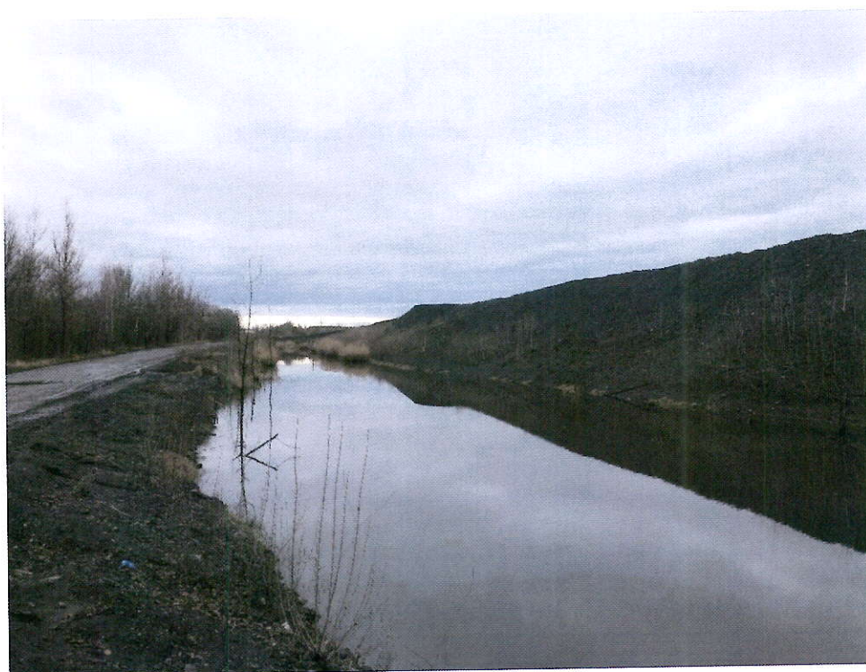
Vodní plocha (zátoka) v obvodovém příkopu kalové nádrže „G“
