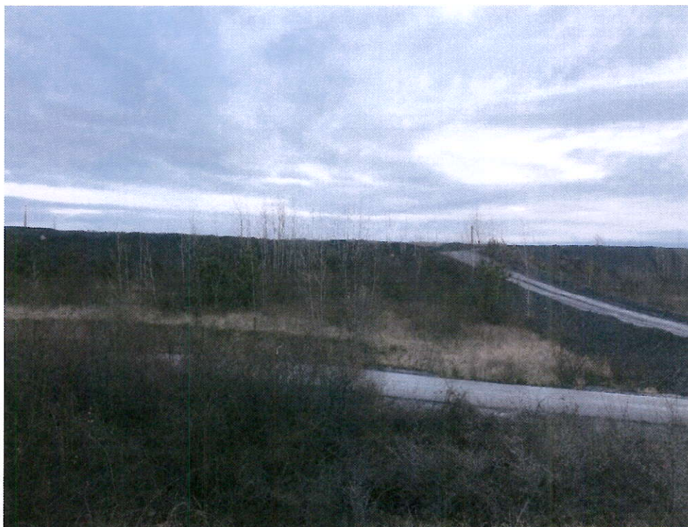
Hráz kalové nádrže „G“ v centrální části poklesů
